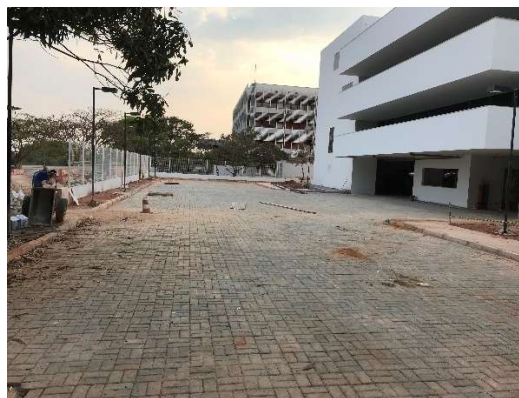
02 – Pavimento de concreto, meio fio, pintura fachada externa fundo.
