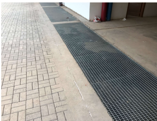
04 – Grade de piso da entrada da garagem, pavimento de concreto.
