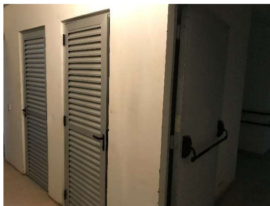
06 – Portas metálicas e corta fogo das escadas.
