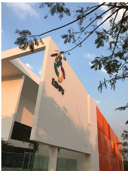
21 – Letreiro externo lateral, brise de fachada, pintura externa.
