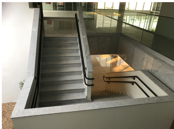
05 – Granito e corrimão duplo de escada, granito de fachada interna com inserte metálico, guarda-corpo.
