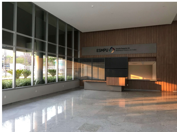
16 – Pannel de revestimento, letreiro interno, balcão, piso de granito, esquadria de alumínio.
