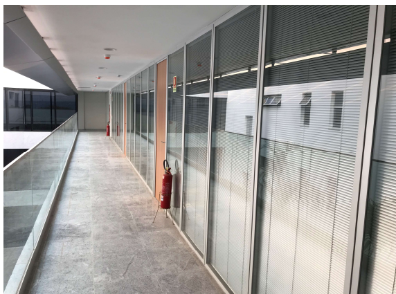
13 – Divisórias de vidro duplo dos corredores, piso de granito, guarda-corpo, forro de gesso c/ pintura.
