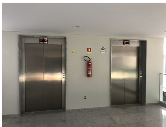
10 – Portas dos elevadores com requadro de granito, sinalização de emergência.
