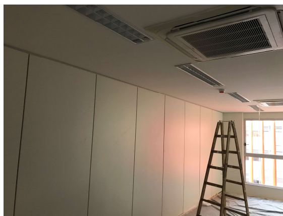
12 – Divisórias “cegas” interior das salas, luminárias e evaporadoras.
