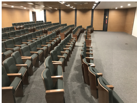
14 – Poltronas auditório, revestimento acústico, luminárias, carpete de piso elevado.
