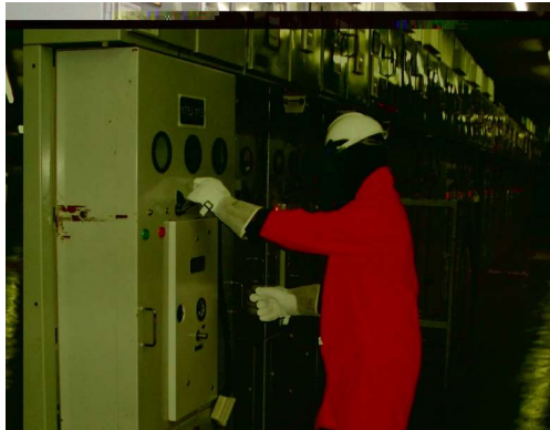
Figura 5 - Operação de equipamento MT - AT em contato indireto em indústria.
