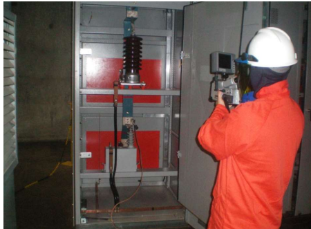
Figura 7 - Atividade de termografia em circuito elétrico de MT/AT – 13,8 kV
